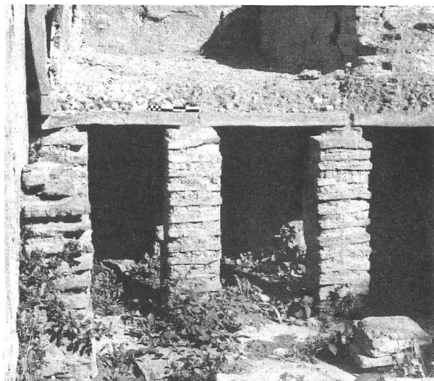
Hypocaustum in tepidario virorum (Pompeis in thermis Stabianis). Bene conspiciuntur pilæ quæ constant e quadratis lateribus mor- tario coagmentatis.
